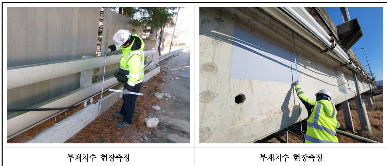
【사진 2.1】 부재 현장측정 전경
